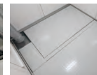
側溝・鋼製溜枳
