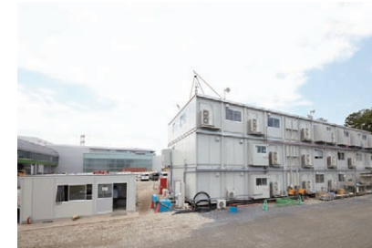
建設現場事務所
