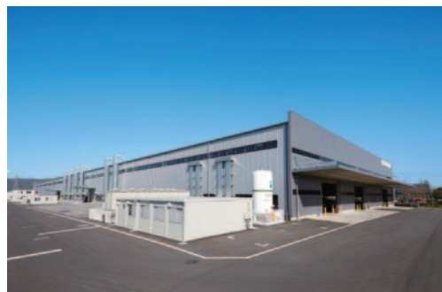
工場棟の外観。奥行5mの庇を設け、雨天時の作業性も考慮しています。
