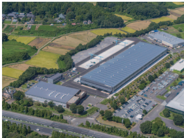
敷地空撮写真
