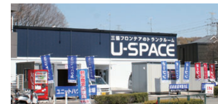
多摩中和田店(トランクルーム)
